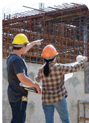
Obras de construcción e ingeniería
